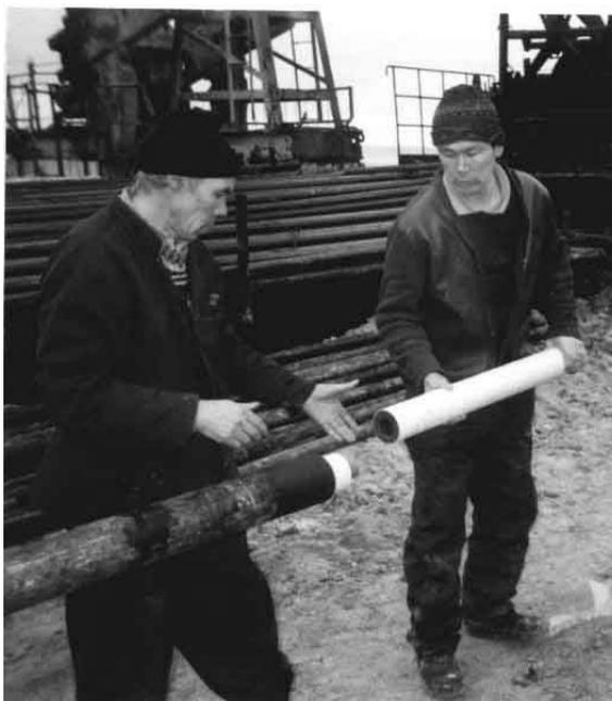
**Рис. 8. Монтаж пороховых зарядов АДС-5 в контейнер из НКТ**
